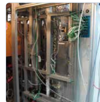
Frontansicht des Diesel-Laborreformers für den Test mit zwei 5 kW SOFC Modulen
